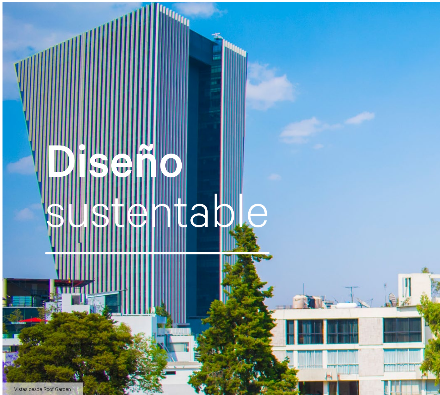
Vistas desde Roof Garden
